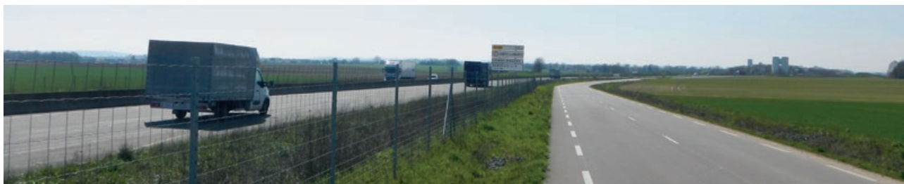
Itinéraire de substitution créé le long de la RN2 à Vaumoise (Oise). ©DREAL Hauts-de-France.
