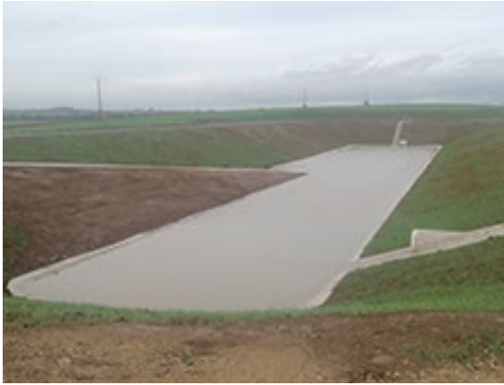
Exemple de bassin d'assainissement. © DREAL Hauts-de-France.
