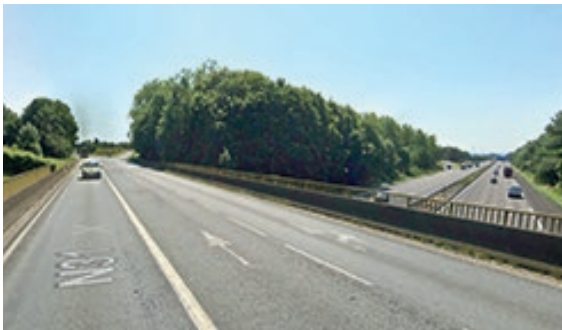
L'ouvrage de franchissement de l'A1. © GoogleMap.
