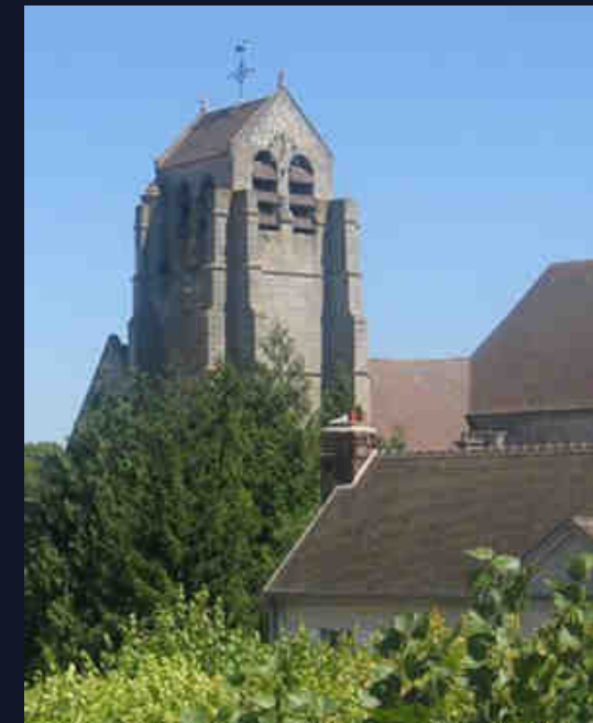
Exemple de toit en bâtière sur le clocher de l'église de Verberie
